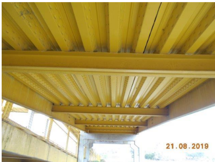
Foto 12 Vista inferior da rampa Oeste.
