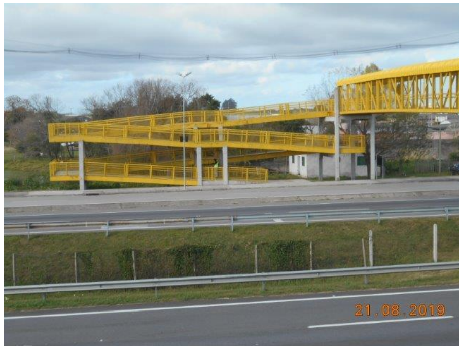
Foto 11 Vista frontal e dos apoios da rampa Leste.
