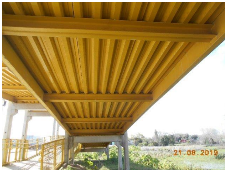
Foto 14 Vista inferior da rampa Leste.
