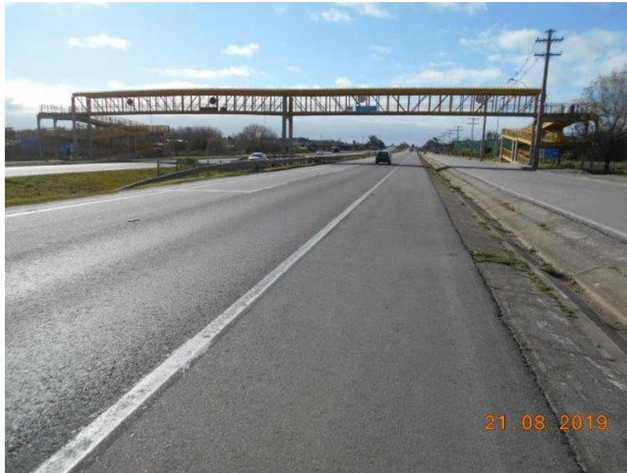
Foto 05 Vista frontal Sul e do apoio na travessia principal.
