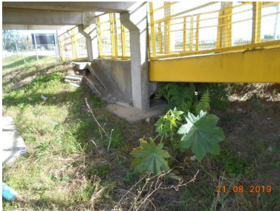
Foto 45 Vista do encontro na rampa Leste.
